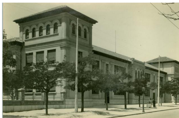
Edificio del Grupo Escolar Giner de los Ríos de Madrid, inaugurado en 1933
